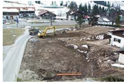
2003 Erweiterung Grundstücktausch und Aushub für den neuen Hoteltrakt.
