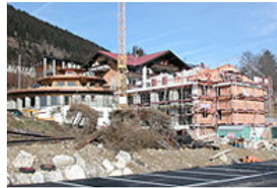
2004 Edelweiss Alpenspa wird gebaut und die alte Kurverwaltung abgerissen, neue Terrasse und Rohbau neuer Hoteltrakt nach Süden, Gartenanlage.
