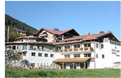
2005 Innenausbau des neuen Hoteltraktes
